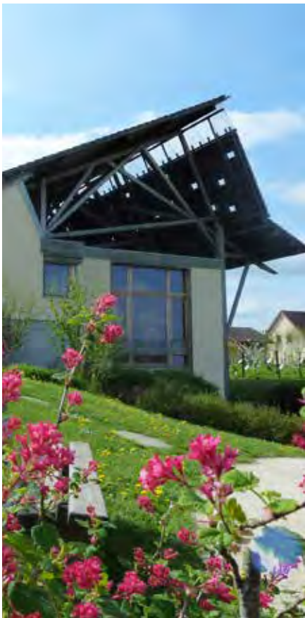
↑ La Damassine, un bâtiment construit dans une démarche de haute qualité environnementale.
